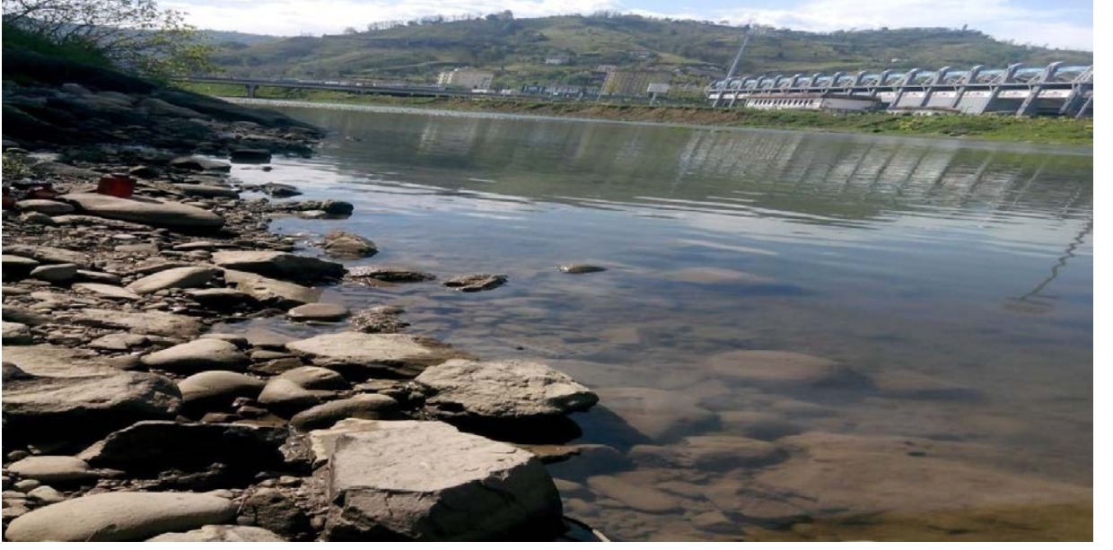
Şekil 3. I Numaralı Örnekleme İstasyonu (Sahil Köprü)
