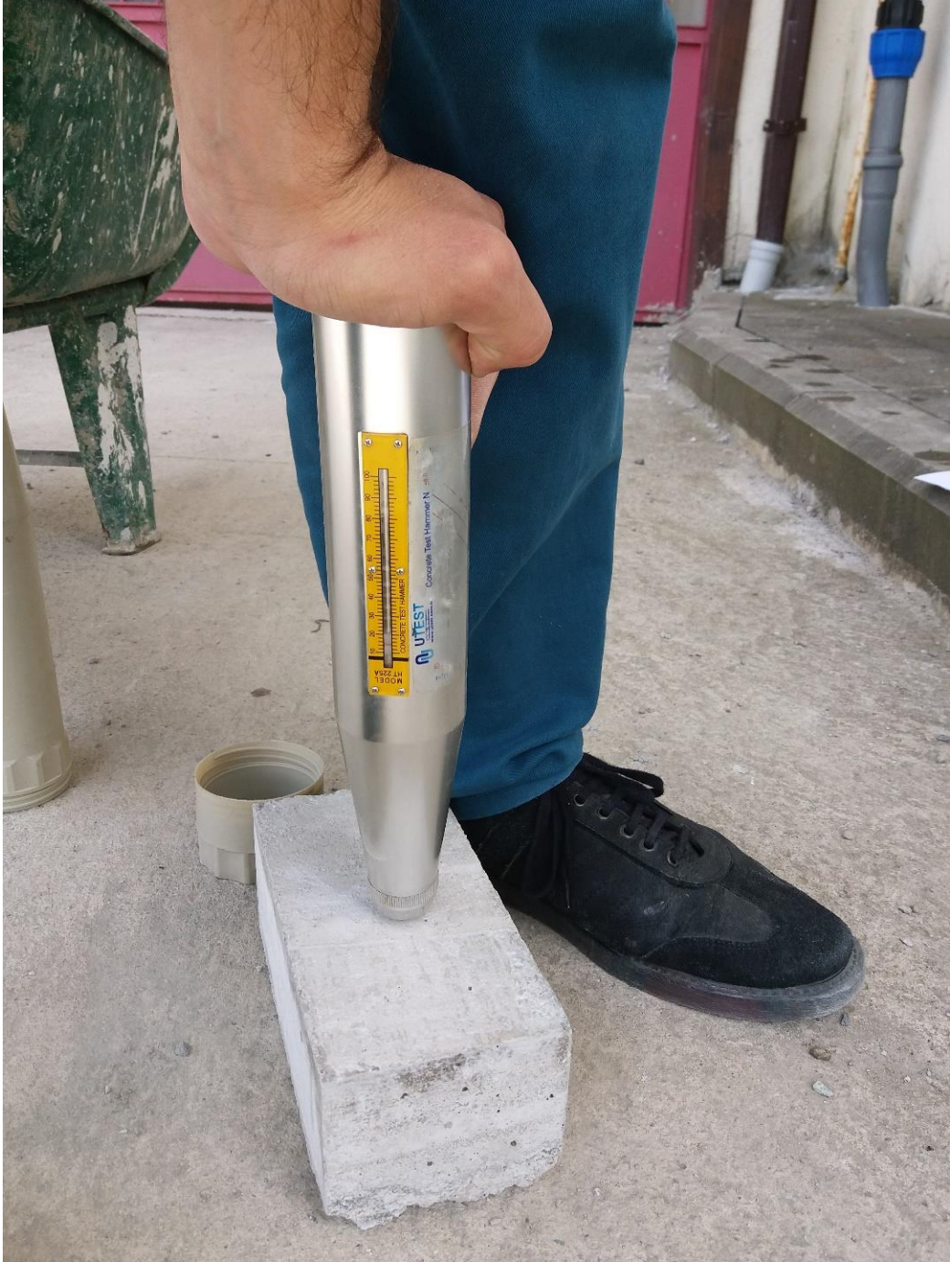
Şekil 16. Schmidt test çekiciyle parkelerde yüzey sertliği ölçümü
