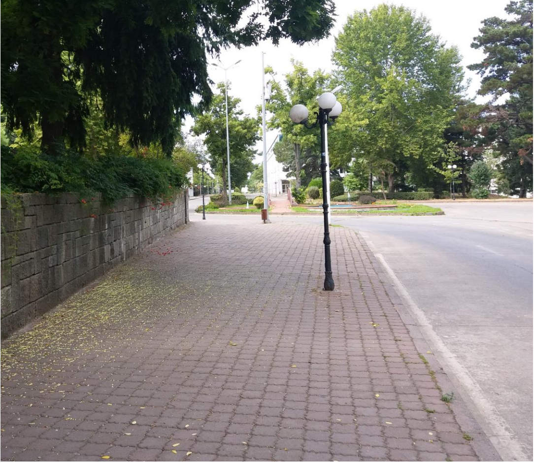
Şekil 4. Kaldırım taşı olarak döşenmiş beton parke taşlar
