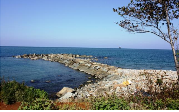
Şekil 5. Çalışma Alanında Hasarlı ve Görev Yapmayan T-mahmuz. Figure 4. Damaged and non functional T-spur in study Area.
