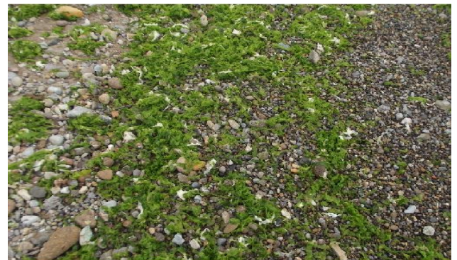
Şekil 8. Mahmuzların iç kısımlarında oluşan yosunlaşma. Figure 8. The seaweed formed in the interior of the spurs.
